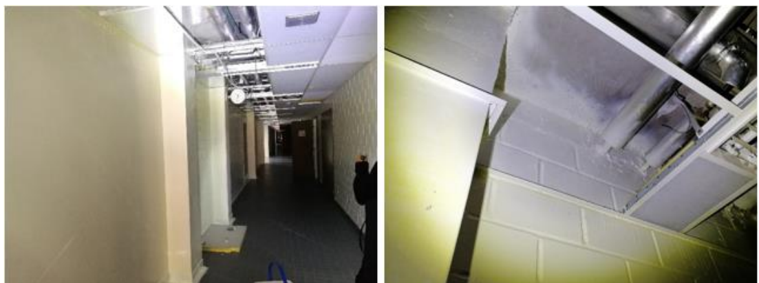
Kuva 20. Käytöstä poistetun ja käytössä olevan alueen väliseiniin on tehty tiivistys ruiskutettavalla tiivistysmassalla (Aerosana Visconn + Contega Solido SL -nauha, Tiivistalo) seinäpinnalle kauttaaltaan. Kuvat käytöstä poistetun alueen puolelta. Tiivistykset ovat aistinvaraisesti havainnoiden pääasiassa tiiviisti toteutettuja.
