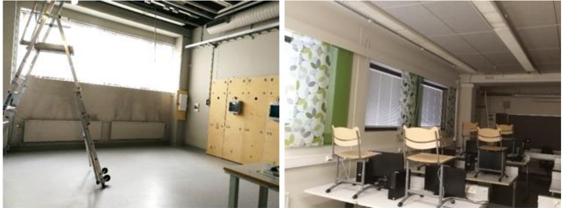
Kuva 13. Yleiskuvat työsalin ja luokkatilan ulkoseinistä. Työsalin kuva työsalista 160 ja luokkatilan kuva luokasta 164.
