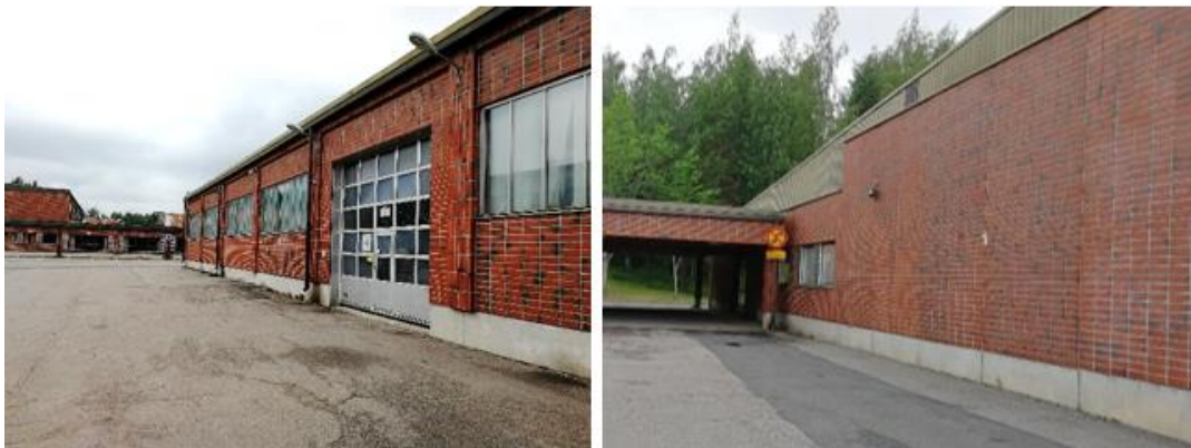
Kuva 14. Yleiskuvat julkisivusta työsalin ja luokkatilan kohdalta.
