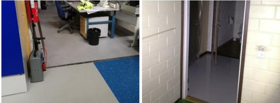
Kuva 6. Vuoden 2022 sisäilmatutkimuksissa (Sweco) havaittujen alapohjan halkeamien kohdat on korjattu pinnoituksella mm. kuvissa esitetyissä tiloissa työsalin 036A ja käytävällä 139.
