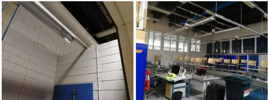
Kuva 19. Yleiskuvia muuratuista ja kevytrakenteisista väliseinistä.
