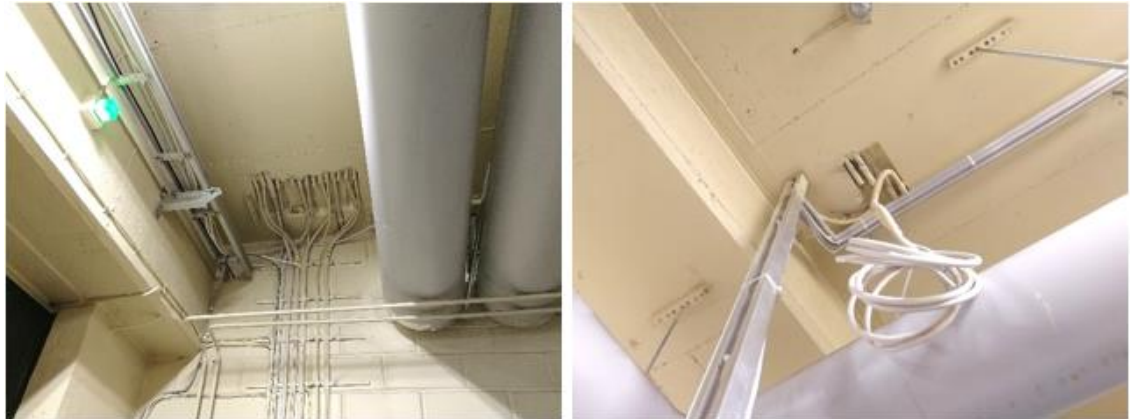
Kuva 14. Lämmönjakohuoneen 259 sähköjohtojen suojaputkien läpiviennit, joiden viereen merkkiainekaasu laskettiin. Lämmönjakohuoneessa eikä muissa talotekniikatiloissa havaittu poikkeavaa hajua.
