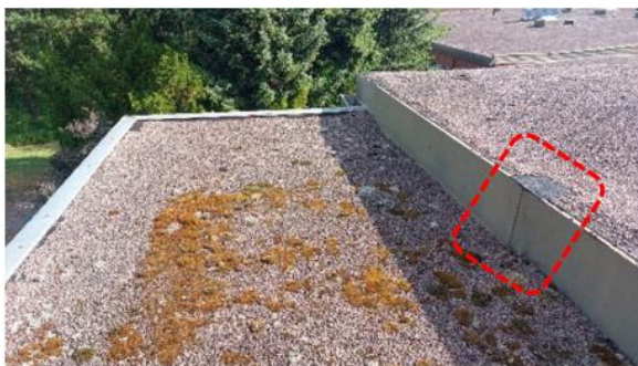
Kuva 33. Eteishallin 416 sisäänkäyntikatos. Lipan ja vesikaton liitoskohdassa oli bitumikermillä tehtyjä paikkakorjauksia peltien saumakohdissa (ympyröity punaisella). Samassa kohdassa eteishallin yläpohjassa havaittiin vanhoja vuotojälkiä (ympyröity punaisella).
