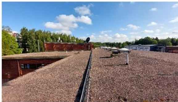
Kuva 32. Kouluosan vesikatto. IV-konehuoneen viereisellä lappeella on runsasta sammalkasvua.
