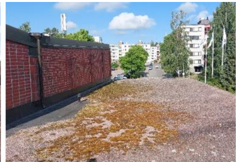
Kuva 32. Kouluosan vesikatto. IV-konehuoneen viereisellä lappeella on runsasta sammalkasvua.
