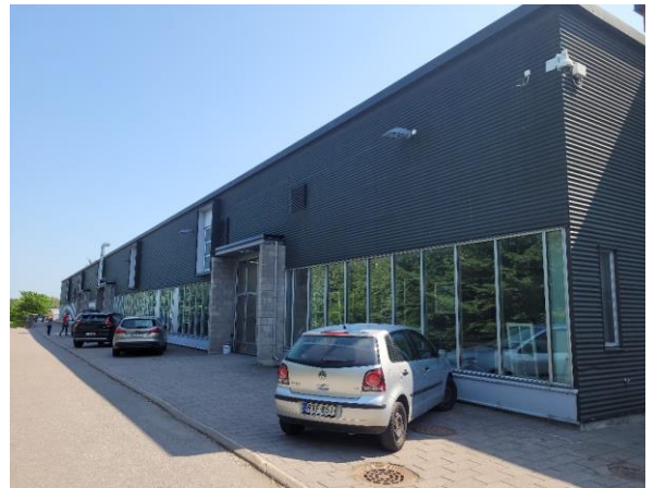
Kuva 3 Yleiskuva D1-osan pohjoisen puoleisesta julkisivusta.
