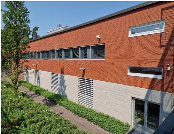
Kuva 2 Yleiskuva D1-osan etelän puoleisesta julkisivusta.
