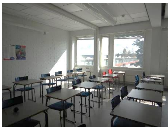
Kuva 7 Yleiskuva A-siiven jo korjatusta luokkatilasta.
