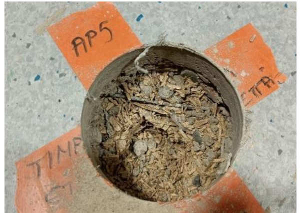
Kuva 12 Näkymä rakenneavaukseen. Alapohjassa eristeenä on toja. Tila on aiemmin ollut märkätila.
