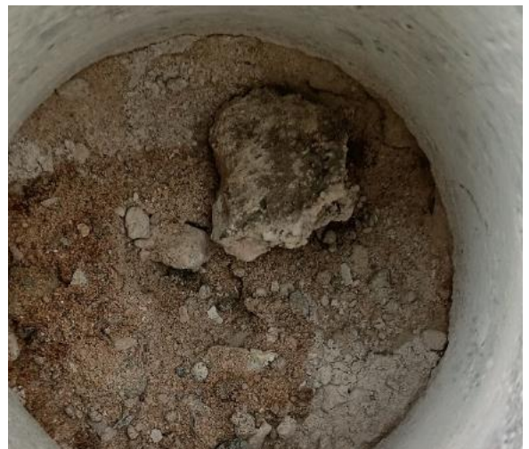
Kuva 6 Betonilaatan alla on hieno hiekka.
