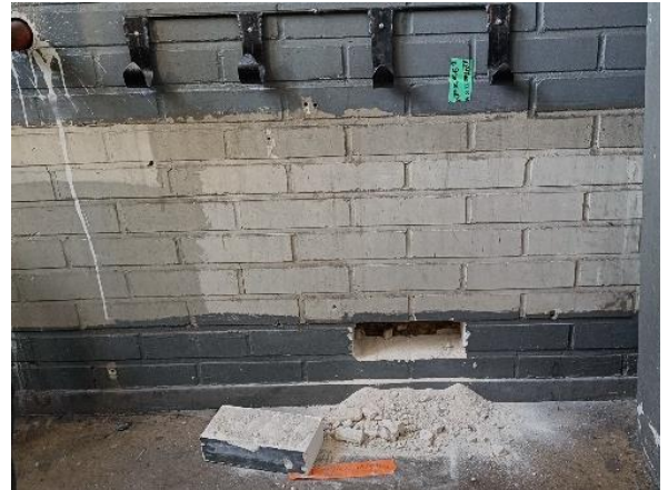
Kuva 58 Hitsaustilan B101 ja G-laajennusosan väliin on jäänyt vanha ulkoseinä väliseinäksi. Näkymä Hitsaustilan B101 suunnasta.
