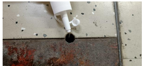
Kuva 92 B-osan kellarikerroksen käytävällä sijaitsevan lattiakanaalin luukku. Ilma virtaa kanaalin suuntaan luukun aukon kautta.
