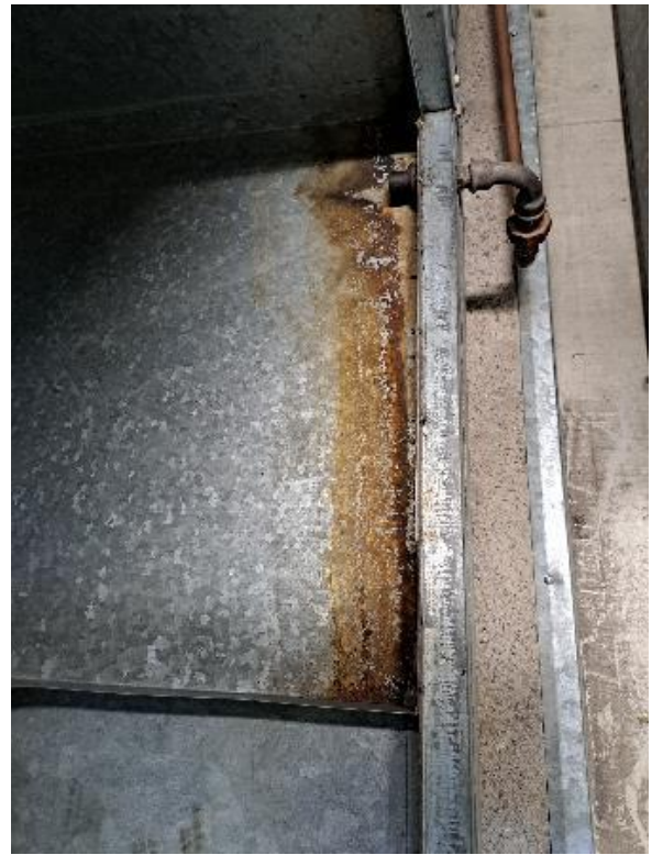
Kuva 111 Kosteusjälkiä suodatinkammiossa.
