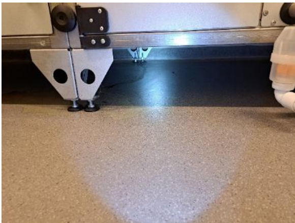
Kuva 104 IV-koneen 52 alla on hieman vesijälkiä, vaikka viemärointi on toteutettu asianmukaisesti.
