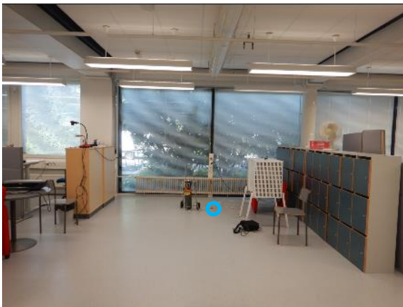
Kuva 20 Huonetilan A214 (MA2) merkkiainetutkimuksessa ei havaittu ilmavuotoa alapohjarakenteen toja-eristekerroksesta huonetilan suuntaan.
