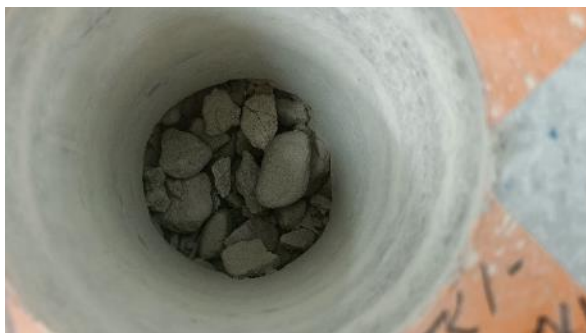
Kuva 45 Alapohjassa eristeenä vaahtolasi-murske-eriste.
