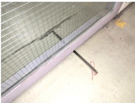
Kuva 81. Hallien ovien alaosat ovat täysin avoimia ja väliseinien kiinteiden ikkunoiden lasituslistan ja lasin välit ovat epätiivitä.
