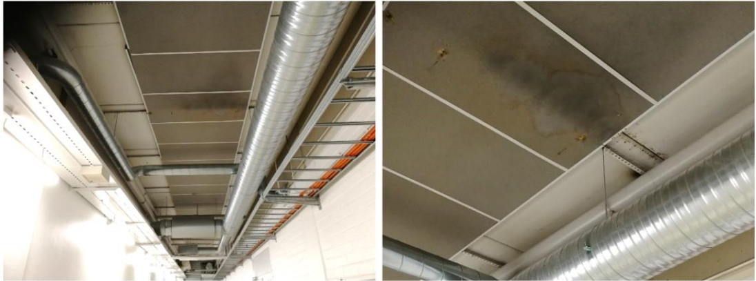
Kuva 43. Kosteusjälkiä 1. kerroksen käytävän 152 katon akustiikkalevyissä. Kosteusjälkiä on useassa kohdassa ja ne sijoittuvat ontelolaatan saumojen kohdalle. Jäljet vaikuttavat olevan vanhoja ja kuivia eikä yläpuolella havaittu selvää syytä kosteusjäljille.
