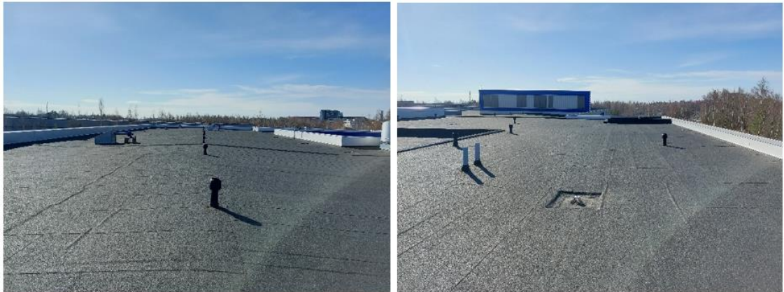
Kuva 203. Yleiskuvia laajennusosan ylemmiltä vesikattotasoilta.
