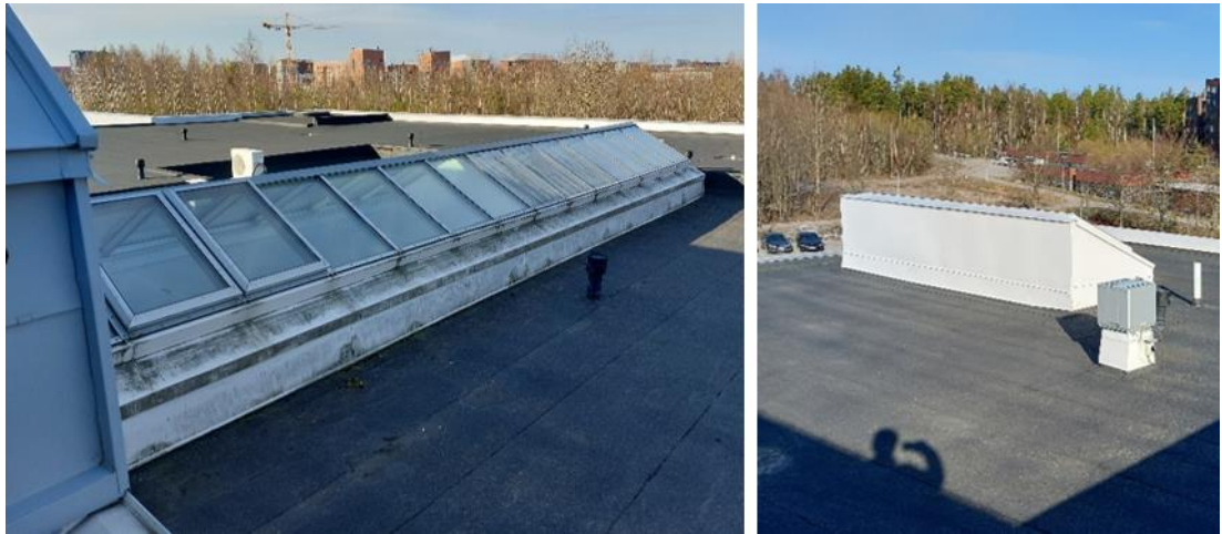
Kuva 109. Yleiskuvia uudemmissa kattoikkunarakenteista.
