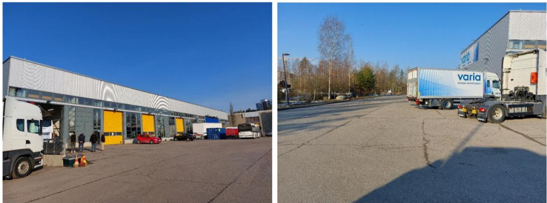
Kuva 147. Rakennuksen itäsivun ja eteläsivun asfalttialueet havaittiin pääosin hyväkuntoisiksi ja kaadoiltaan riittäviksi. Asfalttialueilla havaittiin paikallista halkeilua.
