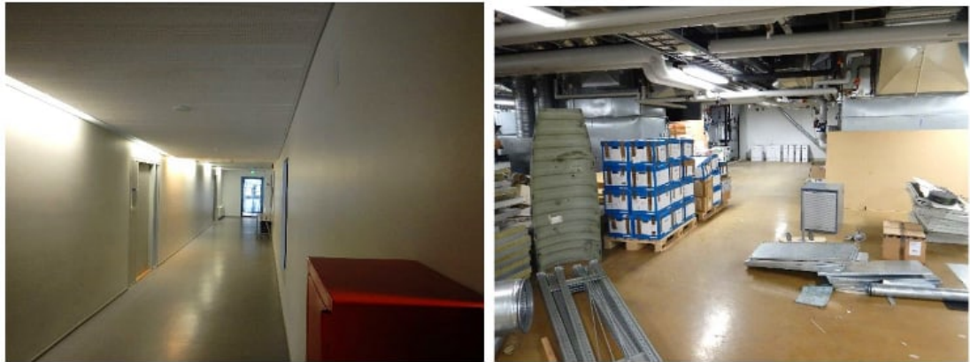
Kuva 178. Yleiskuvat välipohjan pintamateriaaleista. Laajennusosan aulan päädyssä 2. kerroksen käytävällä ja luokkatiloissa on muovimatto. IV-konehuoneessa on pinnoite.
