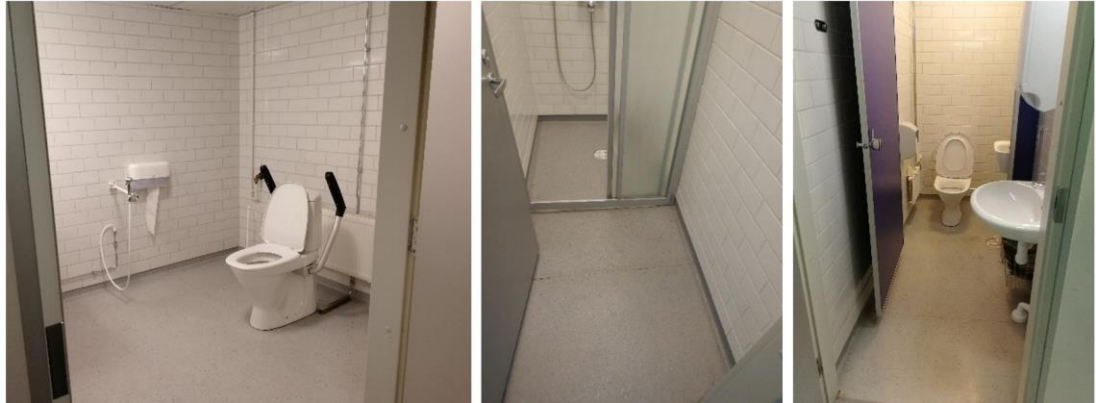
Kuva 160. Yleiskuvat alapohjan pintamateriaaleista. Vessa- ja suihkutiloissa on pääosin märkätilan muovimatto.
