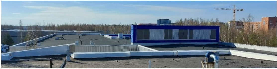
Kuva 202. Laajennusosan vesikattoja kuvattuna alkuperäiseltä osalta.
