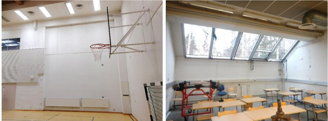
Kuva 26. Yleiskuvat maanvastaisista seinärakenteista. Maanpinta on korkealla maanvastaisen seinälinjan länsipäässä liikuntasalissa ja maanvastainen seinärakenne ulottuu lattiapinnasta korkealle. Liikuttaessa itäpuolelle rakennusta seinälinjaa pitkin, maanpinta madaltuu, ja tilassa 143 (141) maanvastainen seinärakenne on matalampi. Ikkunoiden kohdalla havaittiin vuotojälkiä.
