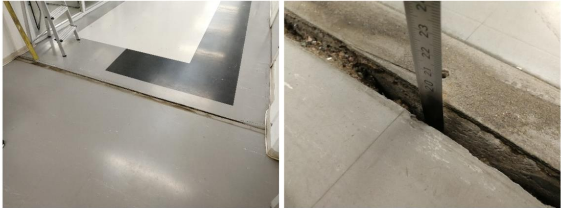
Kuva 45. Välipohjan liikuntasauaman lista irrotettiin (RAK3).
