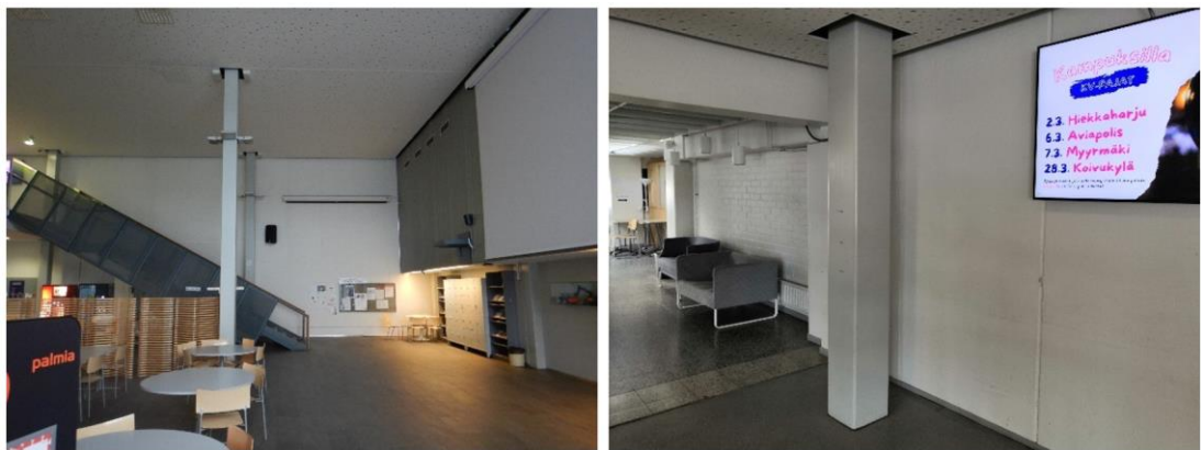
Kuva 231. Yleiskuva aulan ja vanhan puolen hallin 185 yhteisestä seinästä. Seinä on osittain ontelolaattarakenteinen ja osittain tiilirakenteinen.
