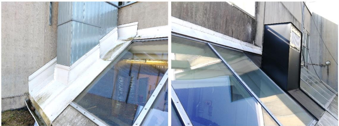
Kuva 65. Vinoikkunoissa on kahdessa kohdassa ulkopuolinen peltilevy IV-läpivientejä varten.
