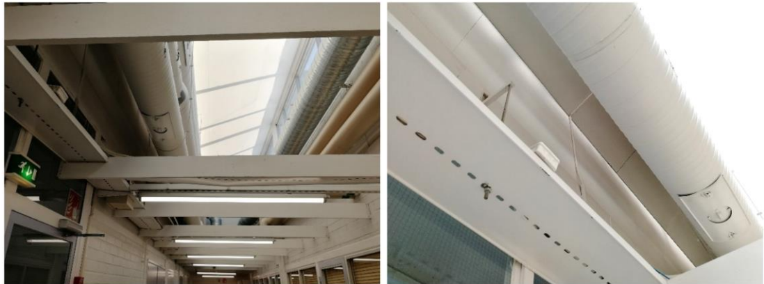
Kuva 51. Yleiskuvat 2. kerroksen käytävän yläpuolella olevan valoaukon ulkoseinästä. Seinässä on maalattu kuitusementtilevy umpinaisella puolella ja ikkunan alapuoli on puhtaaksimuurattua tiiltä.
