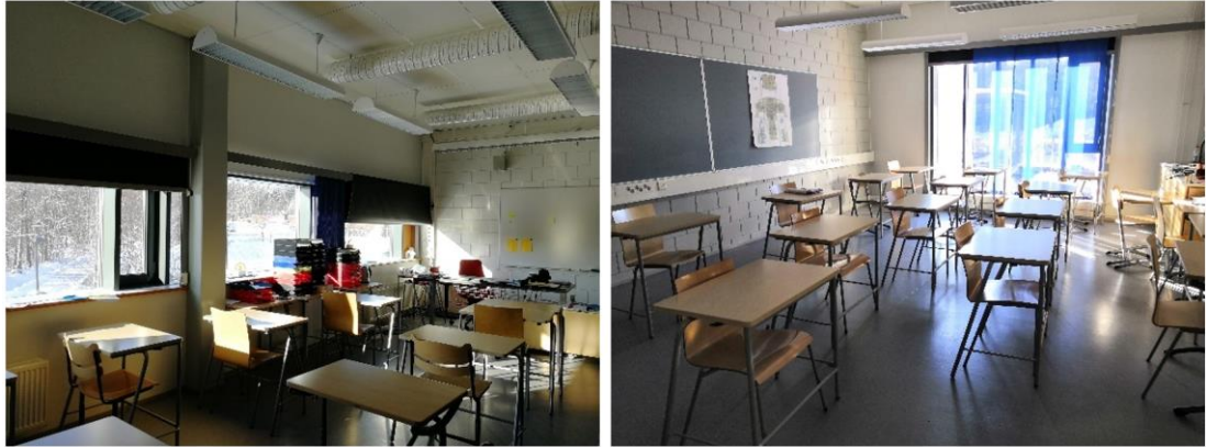
Kuva 185. Yleiskuvat 1. ja 2. kerroksen luokkatilojen maalatuista betonisandwich-elementtiseinistä.
