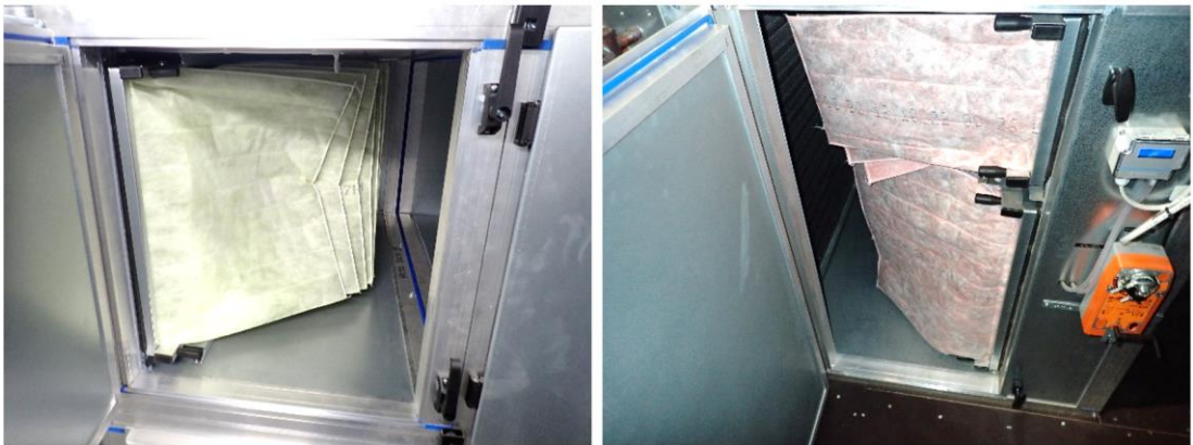
Kuva 127. Yleiskuvat poisto- ja tuloilmansuodatinkammiosta. Iv-koneiden TK312, 313 ja 331 tuloilmakammioiden pohjilla havaittiin jälkiä seisonneesta vedestä, muissa iv-koneissa ei vastaavia havaittu. Kammiot ovat yleisesti puhtaita. Suodatinrungot ovat hyväkuntoisia ja tiiviitä, suodattimet asettuvat niihin tiiviisti. Ulkoilmapellit ovat toimivia ja sulkeutuvat kiinni asentoon koneen sammussa (kaikki rakennuksen iv-koneet sammutettiin).
