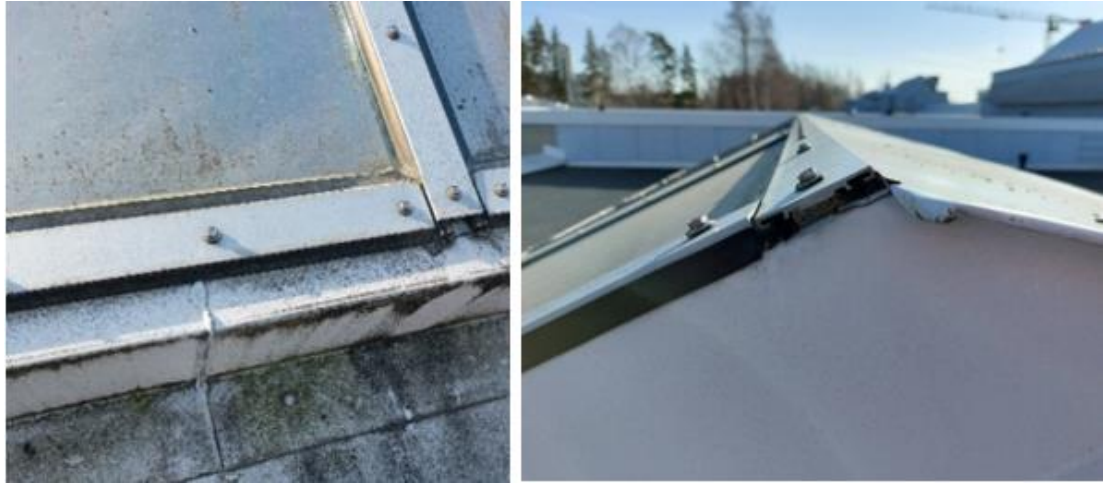
Kuva 111. Lähikuvia uudempien kattoikkunoiden lasituslistoista, joiden alla havaittiin tiiviyyttä parantava alumiinipintainen butyylliteippi.
