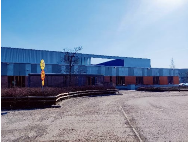
Kuva 150. Yleiskuva rakennuksen länsisivun eteläosasta. Piha-alueet ja niiden rakenteet ja istutukset ja niitä ympäröivät aidat havaittiin pääosin hyväkuntoisiksi.
