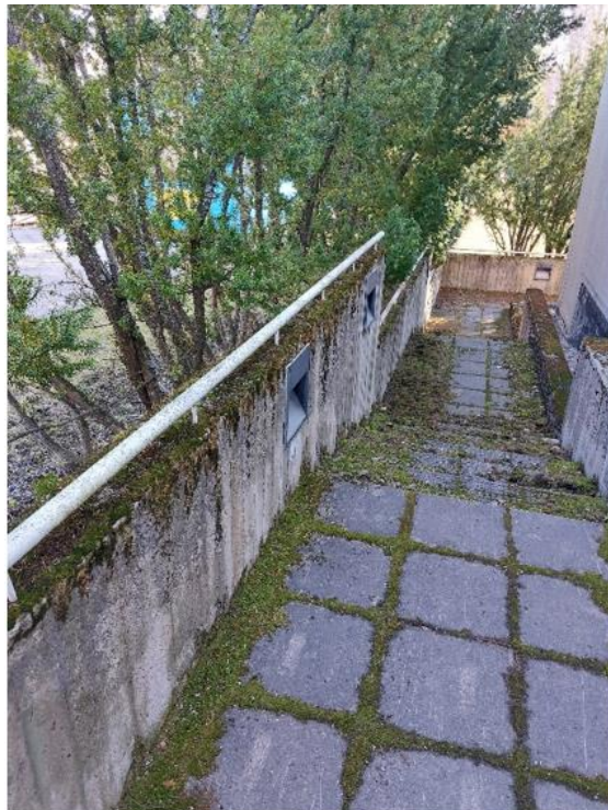
Kuva 9. Rakennuksen luoteisnurkan portaikon laatoitukset havaittiin sammaloituneiksi. Portaissa ja kaiteissa havaittiin rapautunutta betonia. Teräkaiteet havaittiin pintaruosteisiksi.
