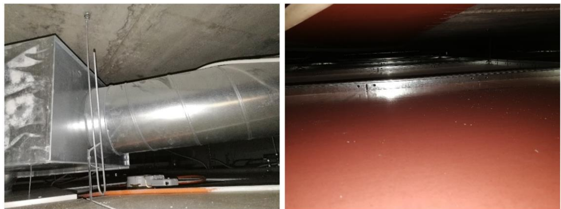
Kuva 218. Tilassa 1082 ja 1034 avattiin alakattoa. Tilassa 1082 oli pölyä alakatossa kulkevien putkien päällä. Tilassa 1034 alakattotilassa oli vähäisesti pölyä.
