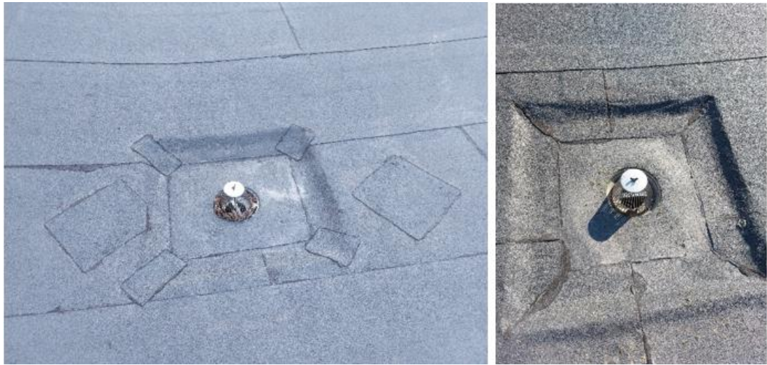
Kuva 208. Pintakermissä on paikoin pieniä paikkakorjauksia. Kattokaivot olivat siistit ja vesi ohjautuu kattokaivoille.
