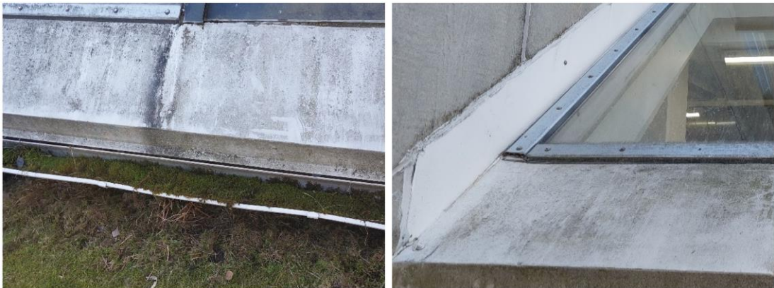
Kuva 63. Vinoikkunoiden vesikourut ovat täynnä roskaa ja sammalta. Kourut ovat vääntyneet todennäköisesti lumen painosta ja/tai pakkautumisesta räystäskouruja vasten. Vanoikkunoiden pellityksen ylösnostojen massa on ikääntynyttä ja aistinvaraisesti havainnoiden epätiiviitä.
