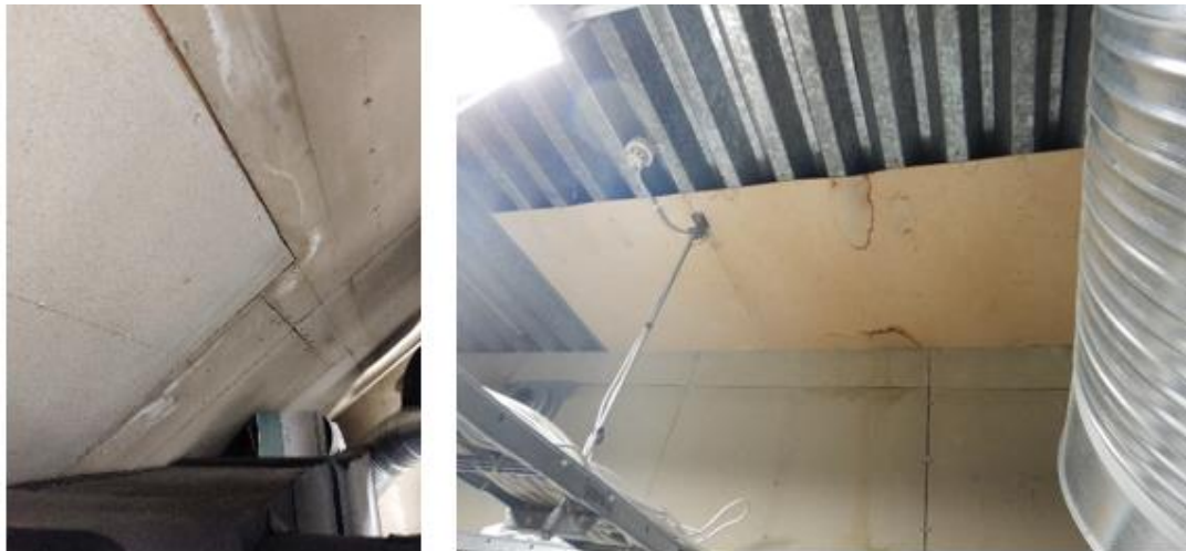
Kuva 118. IV-konehuoneiden vesivuotojälkiä.
