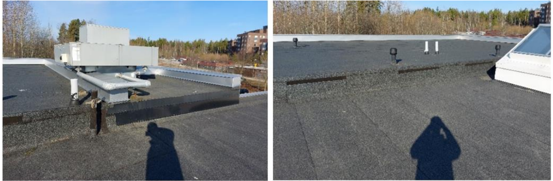
Kuva 101. Yleiskuvia alkuperäisen osan ja laajennusosan liitoskohdasta, jossa on pieni tasoero. Alkuperäisen osan bitumikermejä on uusittu (tai alkuperäisen kermin päälle on asennettu pintakermi) vuonna 2006, laajennusosan rakentamisajankohtana.
