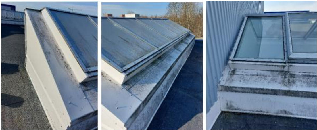
Kuva 110. Lähikuvia uudempien kattoikkunoiden pellityksistä. Pellitysten liitoskohtia on tiivistetty joustavilla massoilla. Pellitykset ja lasit ovat likaantuneet.
