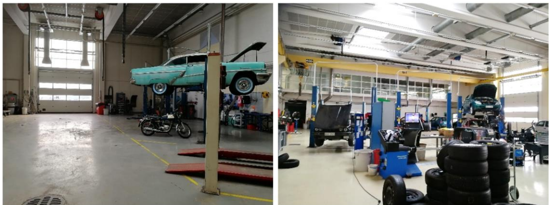
Kuva 19. Yleiskuvat alapohjan pintamateriaaleista. Hallitiloissa on pinnoite/maalattu betoni.
