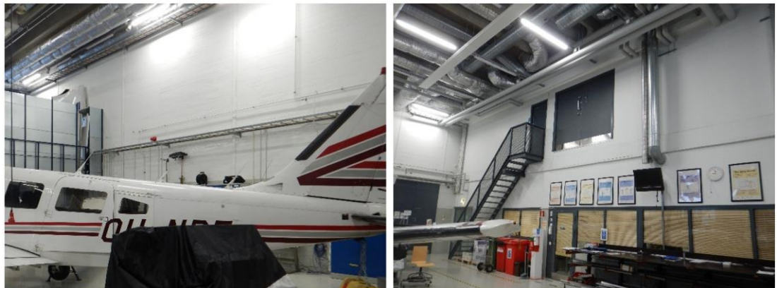
Kuva 196. Yleiskuvat tilojen väliseinistä. Hallitilojen väliseinien muuraukset ovat pääasiassa slammattuja. Hallien ja hallien yhteydessä olevien opettajien huoneiden välisissä väliseinissä on kiinteät ikkunat, joiden yläpuoli on levytetty.
