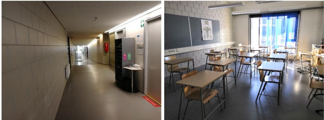
Kuva 157. Yleiskuvat alapohjan pintamateriaaleista. Käytävällä ja luokkatiloissa on muovimatto.
