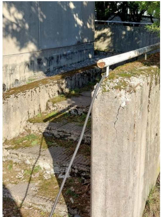
Kuva 9. Rakennuksen luoteisnurkan portaikon laatoitukset havaittiin sammaloituneiksi. Portaissa ja kaiteissa havaittiin rapautunutta betonia. Teräkaiteet havaittiin pintaruosteisiksi.
