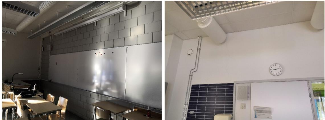
Kuva 195. Yleiskuvat tilojen väliseinistä. Väliseinät ovat pääosin harkkorakenteisia ja niiden pinta vaihtelee puhtaaksimuuratun, slammatun ja rapatun välillä.
