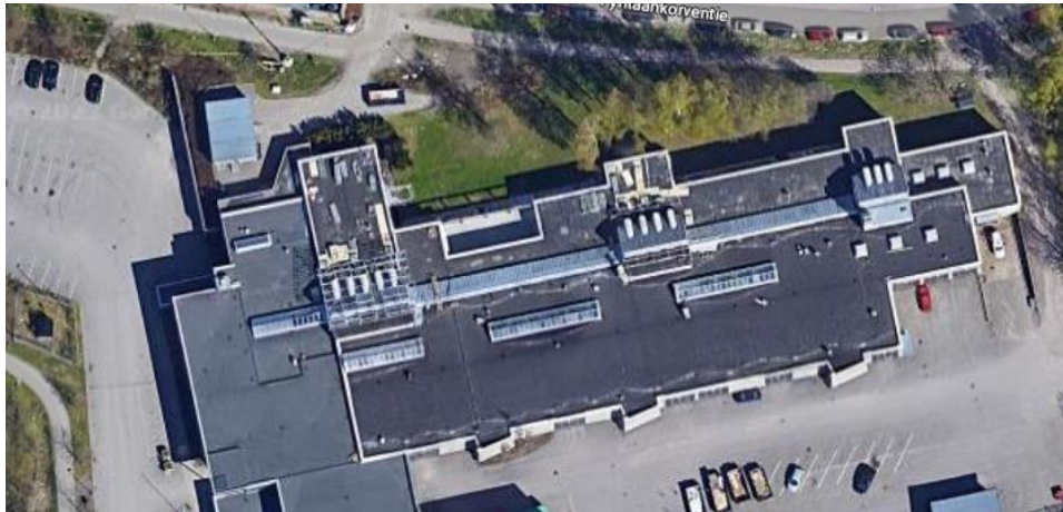
Kuva 93. Alkuperäisen osan vesikattoja. Lähde: maps.google.fi.
