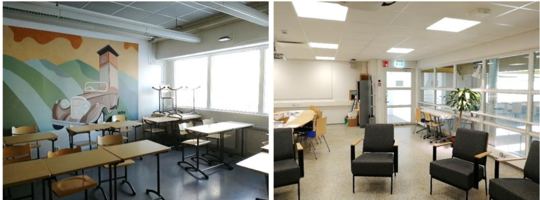
Kuva 39. Yleiskuvat välipohjan pintamateriaaleista. Opetustiloissa on vinyylilaatoitus. Hallien välisissä kokoustiloissa on muovimainen pinnoite.
