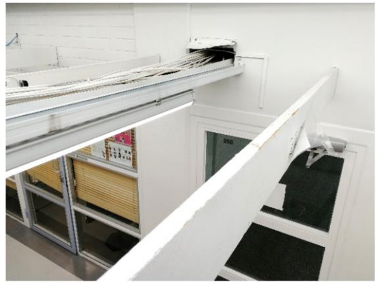
Kuva 80. Väliseinissä on paljon epätiivitä läpivientejä. Tiivistämättömiä läpivientejä on halleista ympäröiviin rakenteisiin ja näistä edelleen seuraaviin tiloihin.
