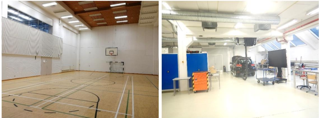
Kuva 18. Yleiskuvat alapohjan pintamateriaaleista. Liikuntasalissa on hyväkuntoinen joustoparketti. Luokkatiloissa on pinnoite/maalattu betonipinta.
