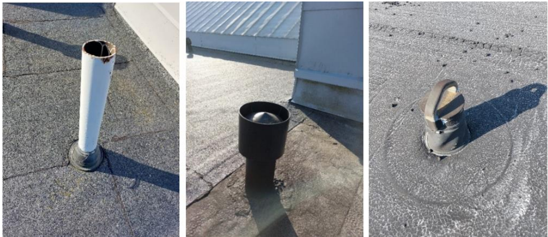
Kuva 104. Läpivientien toteutustapoja: valurautainen viemäriputki korjatulla katto-osalla, alipainetuuletin ja kattopollari. Läpiviennit vaikuttivat tiiviiltä. Muutamissa läpivienneissä on käytetty EPDM-kumilaippaa (viemäriputken läpivienti) mikä viittaa jälkikäteen tehtyyn asennukseen.
