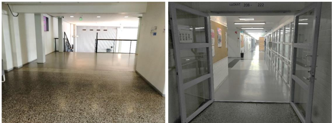
Kuva 38. Yleiskuvat välipohjan pintamateriaaleista. Aulan alkuperäisen rakennusosan alueella on pääosin mosaiikkibetonilaatta. 2. kerroksen käytävällä on vinyylibetoni.
