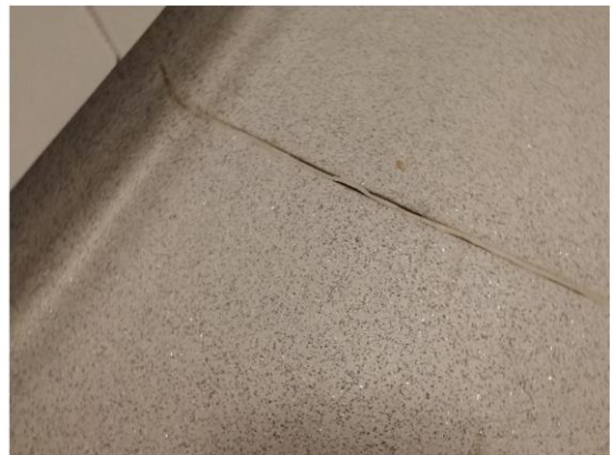
Kuva 163. Siivouskeskuksessa 1056 ja suihkutiloissa 1047, 1048 ja 1049 havaittiin muovimaton saumojen ratkeilua. Siivouskeskuksessa ratkenneen sauman kohdalla oli vettä ja vesi on päässyt maton alle. Suihkutilojen ratkenneiden saumojen ympärillä ei havaittu kohonneita pintakosteusilmaisimen lukemia. Suihkutilojen kynnykset ovat osittain epätiivisiä ja vettä voi päästä näiden alle.
