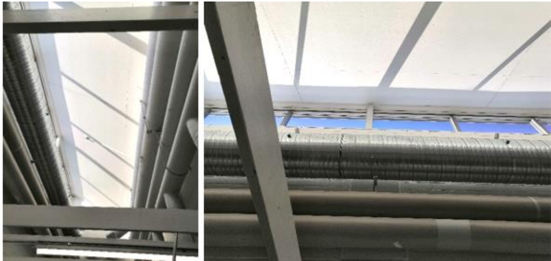
Kuva 117. Yleiskuvia käytävältä kohti ikkunoita ja vesikattorakennetta YP5. Rakenteen kohdalla ei havaittu vuotojälkiä. Talotekniikka-asennusten päälle oli kertynyt pölyä.
