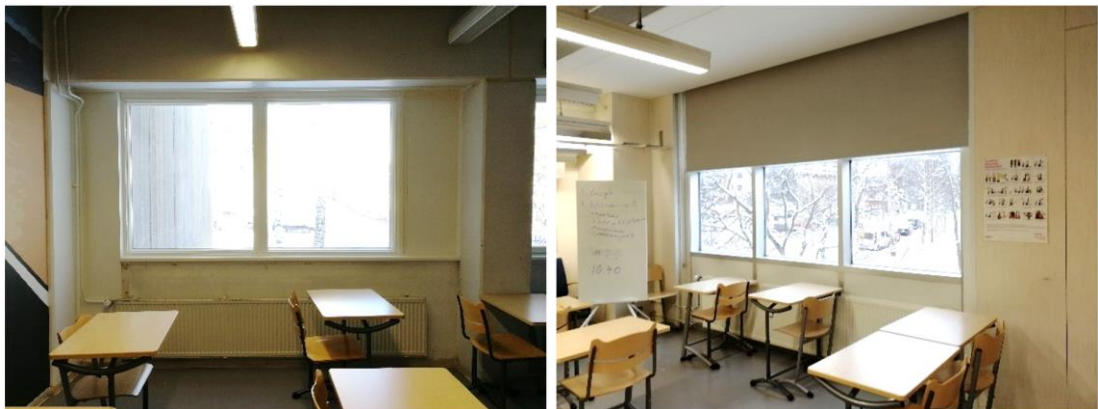
Kuva 52. Yleiskuvat 2. kerroksen luokkatilojen ulkoseinistä. Ulkoseinissä on ikkunauhan alapuolella lähtötietojen ja havaintojen perusteella vaakasuuntainen ontelolaattarunko. Pinnat ovat siistit. Pilari-palkkirunko kulkee ulkoseinälinjan sisäpuolella. Tilassa 233 (215) on kaistale ulkoseinää, joka on toteutettu teräsprofiilijärjestelmällä.
