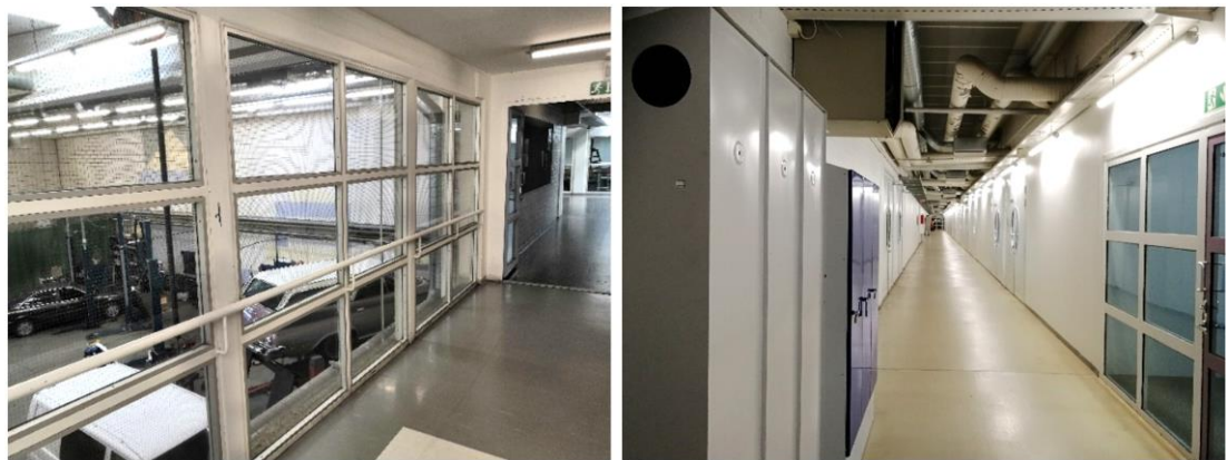
Kuva 77. Yleiskuvat 1. ja 2. kerroksen käytävän väliseinistä, joista halleihin päin on 2. kerroksessa kiinteät ikkunat ja 1. kerroksessa ikkunalliset ovet.
