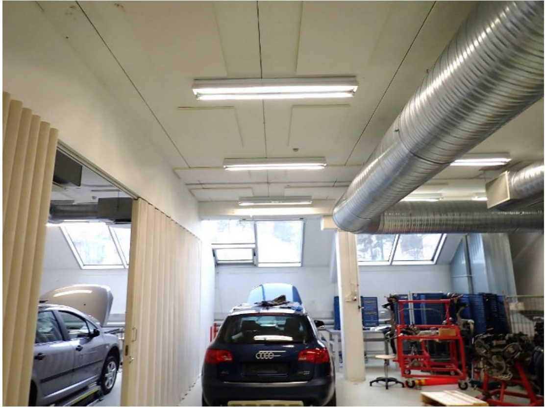
Kuva 141. Yleiskuva työsalista 133. Sali on erotettu kevyellä sermillä salista 131. Ilmanvaihdon toteutus ei vastaa lähtötietoina toimitettuja ilmanvaihtopiirustuksia. Päätelaitteiden sijoittelu tiloissa ei ole ilmanjaon toiminnan kannalta optimaalista.
