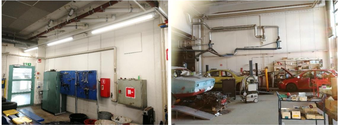
Kuva 53. Yleiskuvat hallitilojen ontelolaatta-ulkoseinistä.
