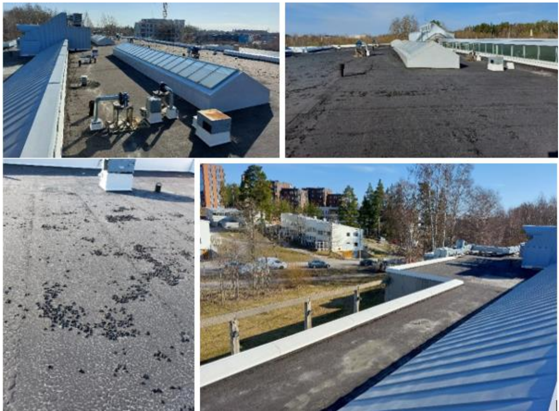
Kuva 97. Yleiskuvia alkuperäisen osan bitumikermikatoista, joihin on asennettu sirotepintainen pintakermi.
