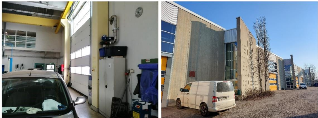
Kuva 54. Yleiskuvat hallitilojen ulkoseinistä ja nosto-ovesta sisä- ja ulkopuolelta.
