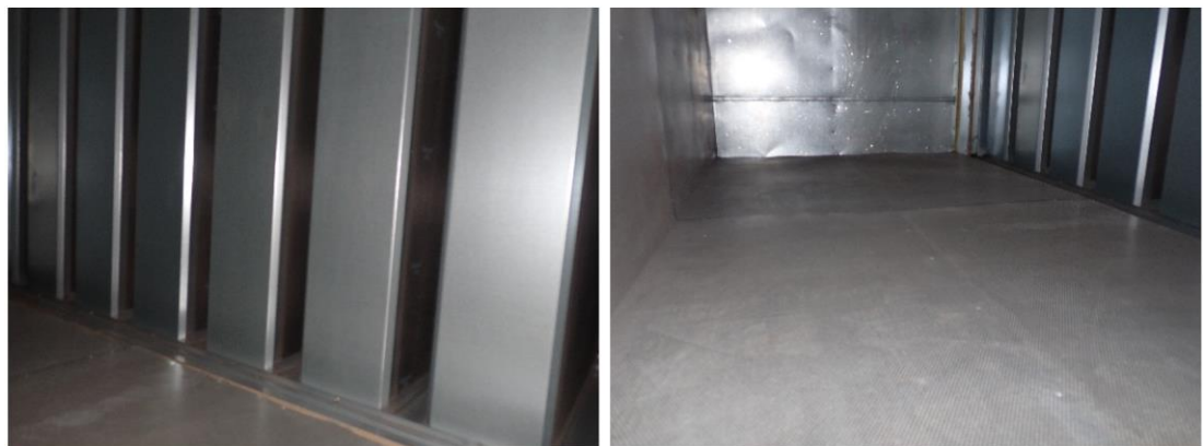
Kuva 224. Yleiskuvat iv-koneiden äänenvaimentimista ja puhalluskammiosta. Äänenvaimennusmateriaali on lasikuitukankaalla suojattu mineraalivilla ja kammioiden muovikalvolla suojattu mineraalivilla. Kammiot ovat hyväkuntoisia ja suojamateriaalit ehjiä. Poistoilmakammiot ovat hieman likaisia.
