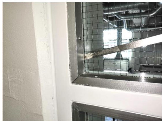
Kuva 81. Hallien ovien alaosat ovat täysin avoimia ja väliseinien kiinteiden ikkunoiden lasituslistan ja lasin välit ovat epätiivitä.
