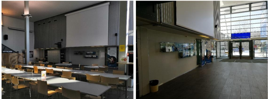
Kuva 234. Yleiskuva aulan ja uuden puolen hallin 1041 yhteisestä seinästä. Seinä on osittain harkkorakenteinen ja aulan puolella on suuri kotelo, jossa kulkee talotekniikkaa.
