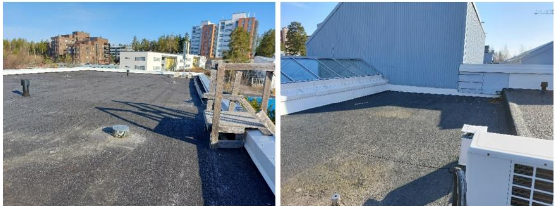
Kuva 97. Yleiskuvia alkuperäisen osan bitumikermikatoista, joihin on asennettu sirotepintainen pintakermi.
