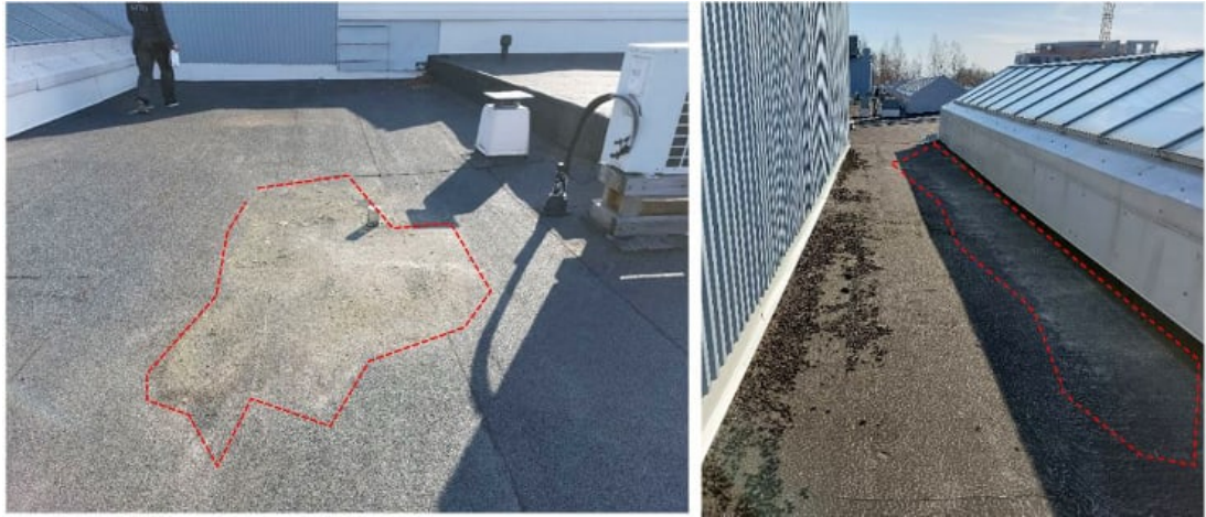
Kuva 103. Jälkiä veden paikallisesta lammikoitumisesta on rajattu kuviin punaisella katkoviivalla.
