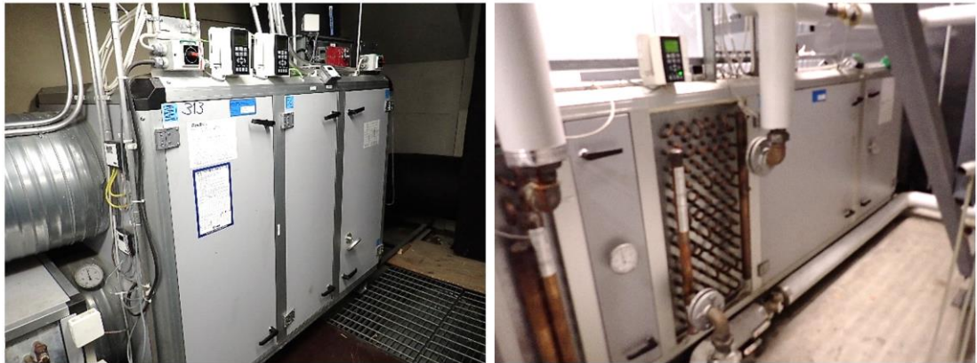
Kuva 126. Yleiskuvat vanhemmista vuoden 2008 ilmanvaihtokoneista. Koneet ovat silmämääräisesti arvioituna tyydyttävässä kunnossa.
