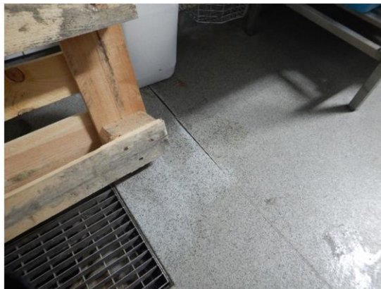
Kuva 163. Siivouskeskuksessa 1056 ja suihkutiloissa 1047, 1048 ja 1049 havaittiin muovimaton saumojen ratkeilua. Siivouskeskuksessa ratkenneen sauman kohdalla oli vettä ja vesi on päässyt maton alle. Suihkutilojen ratkenneiden saumojen ympärillä ei havaittu kohonneita pintakosteusilmaisimen lukemia. Suihkutilojen kynnykset ovat osittain epätiivisiä ja vettä voi päästä näiden alle.
